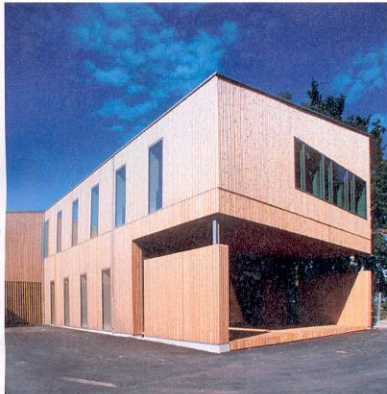
1 Thermoholzfassade eines Sonderwohnheims in Garbsen (D). Die höhere Witterungsresistenz von Thermoholz bewirkt zusammen mit dem flächigen Fenstereinsatz sowie dem fehlenden Dachvorsprung eine regelmäßige Vergrauung der Fassade (Despang Architekten, Hannover. Bild: Olaf Baumann)
